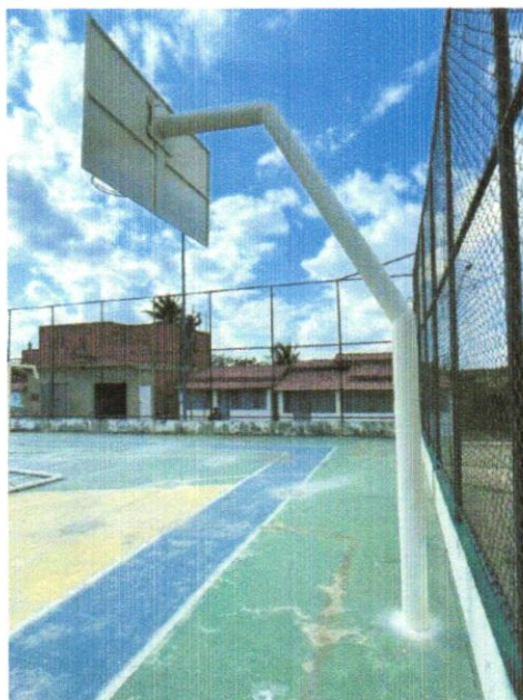
FOTO 06 – INSTALAÇÃO DE TABELA PARA BASQUETE OFICIAL EM LAMINADO NAVAL, MEDINDO 1,80 X1,20M, INCLUINDO, AROS FIXO METAL E REDES
