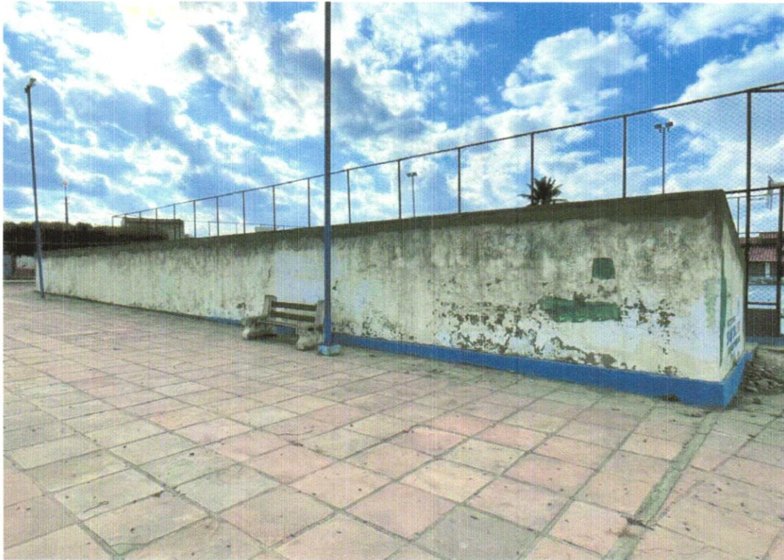
FOTO 19 – EMBOÇO OU MASSA ÚNICA EM ARGAMASSA TRAÇO 1:2:8, PREPARO MANUAL, APLICADA MANUALMENTE EM PANOS DE FACHADA COM PRESENÇA DE VÃOS, ESPESSURA DE 45 MM. AF_06/2014.
