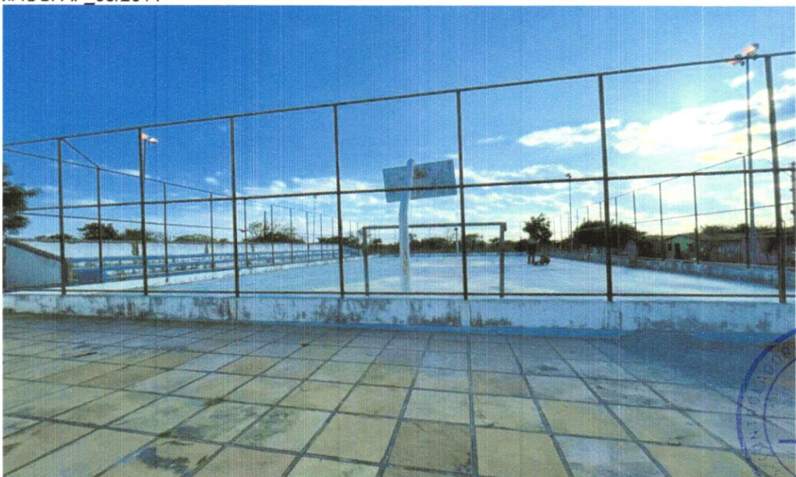
FOTO 16 – INSTALAÇÃO DE REFLETOR SLIM LED 200W DE POTÊNCIA, BRANCO, FRIO, 6.500K, AUTOVOLT, ARCA G-LIGHT OU SIMILAR.
