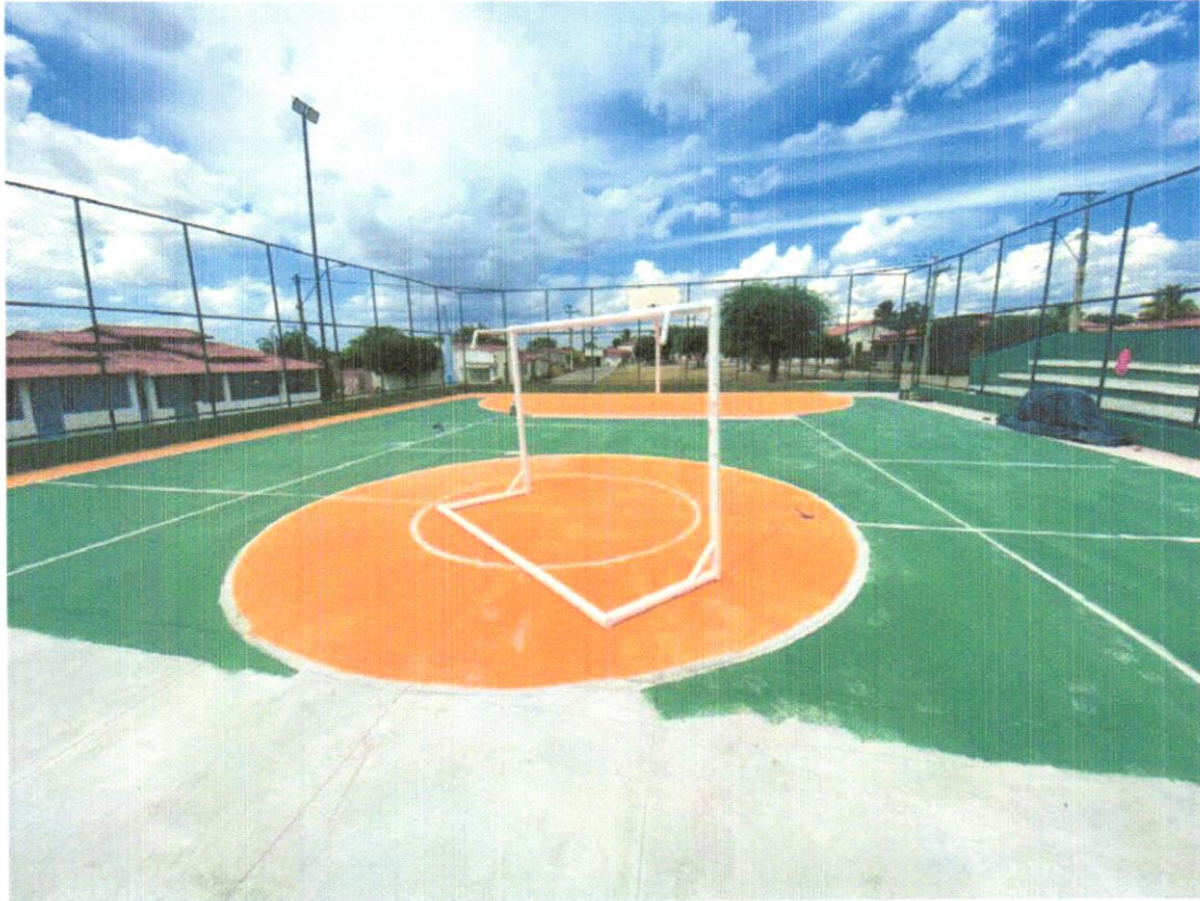
FOTO 03 – PINTURA ESMALTE EM ESTRUTURA METÁLICA, DUAS (2) DEMÃOS, INCLUSIVE, UMA DEMÃO DE FUNDO ANTICORROSIVO.
