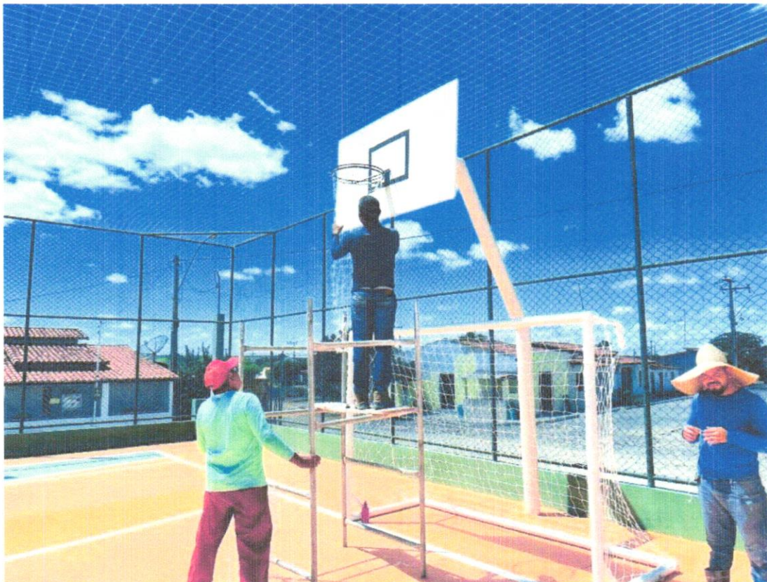
FOTO 05 - INSTALAÇÃO DE TABELA PARA BASQUETE OFICIAL EM LAMINADO NAVAL, MEDINDO 1,80 X1,20M, INCLUINDO, AROS FIXO METAL E REDES
