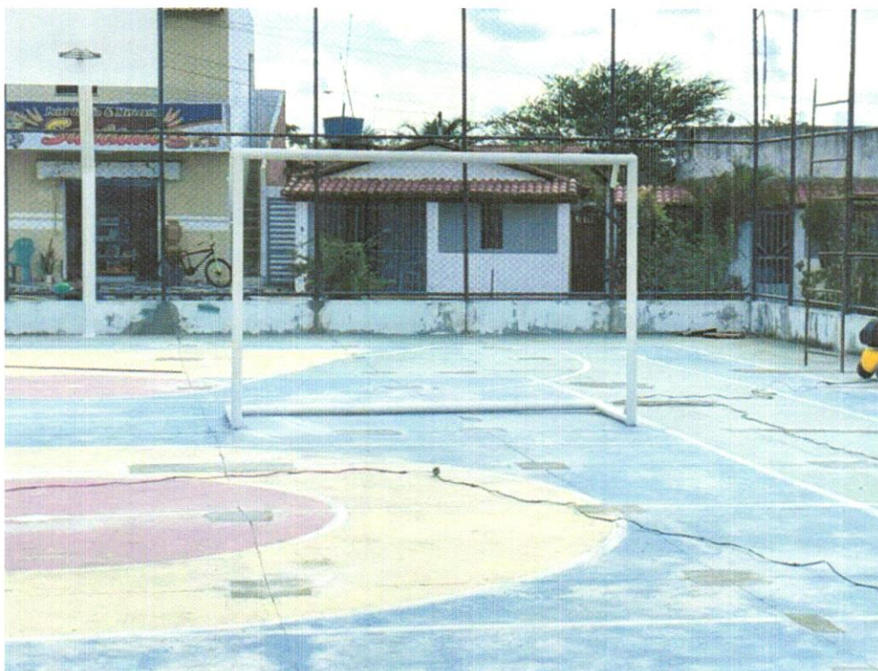
FOTO 17 – TRATAMENTO DE FISSURAS COM ARGAMASSA INDUSTRIALIZADA – MASSA RÁPIDA REBOTEC OU SIMILIAR (SEÇÃO ATÉ 5 X 5 CM)
