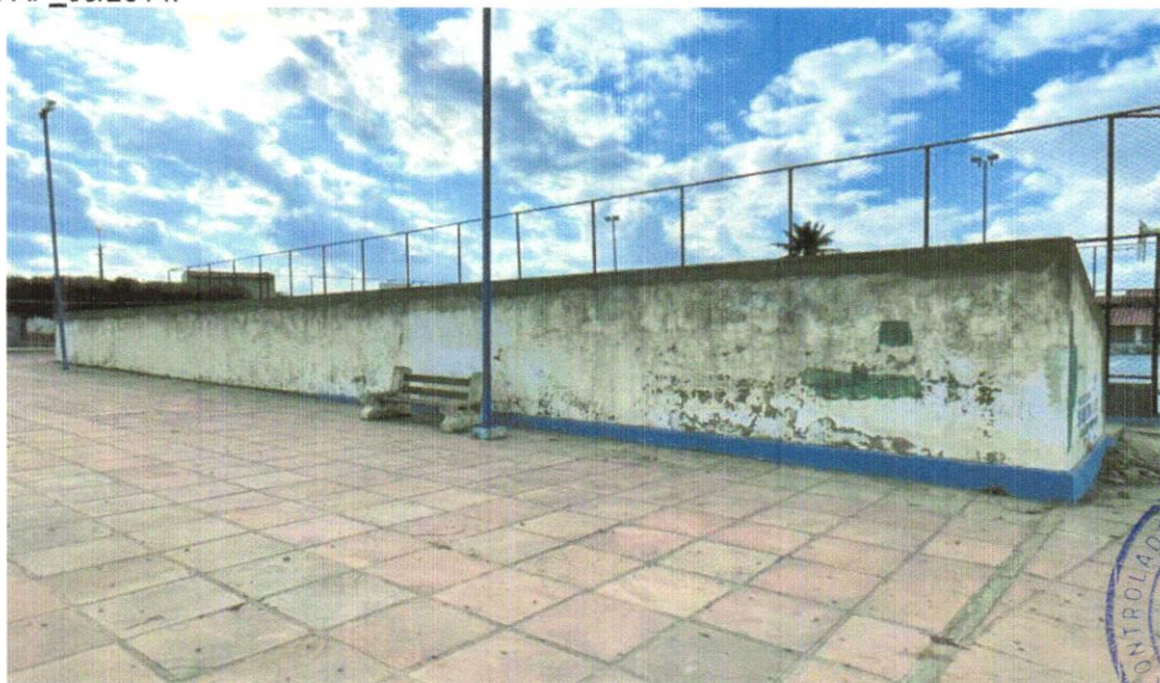
FOTO 20 – EMBOÇO OU MASSA ÚNICA EM ARGAMASSA TRAÇO 1:2:8, PREPARO MANUAL, APLICADA MANUALMENTE EM PANOS DE FACHADA COM PRESENÇA DE VÃOS, ESPESSURA DE 45 MM. AF_06/2014.
