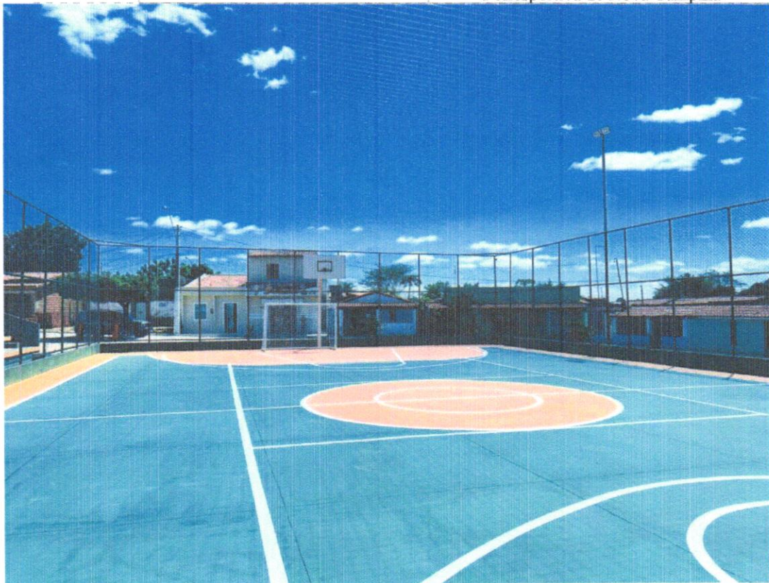
FOTO 01 – INSTALAÇÃO DE TELA DE PROTEÇÃO DE NYLON (3,6MM), MALHA 10X10CM
